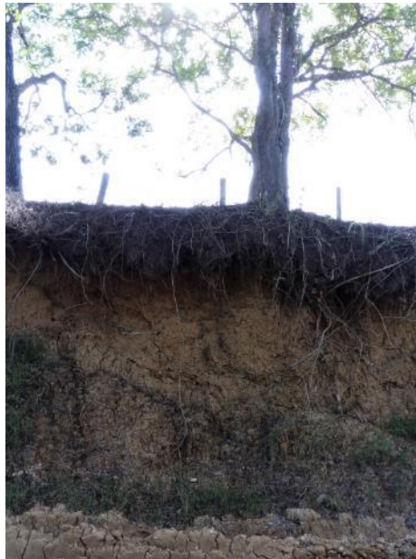
Figura 65 Afloramiento rocas Formación Zambrano bastante alteradas, municipio de Pijiño del Carmen. (9.546676N, -74.142626W)
