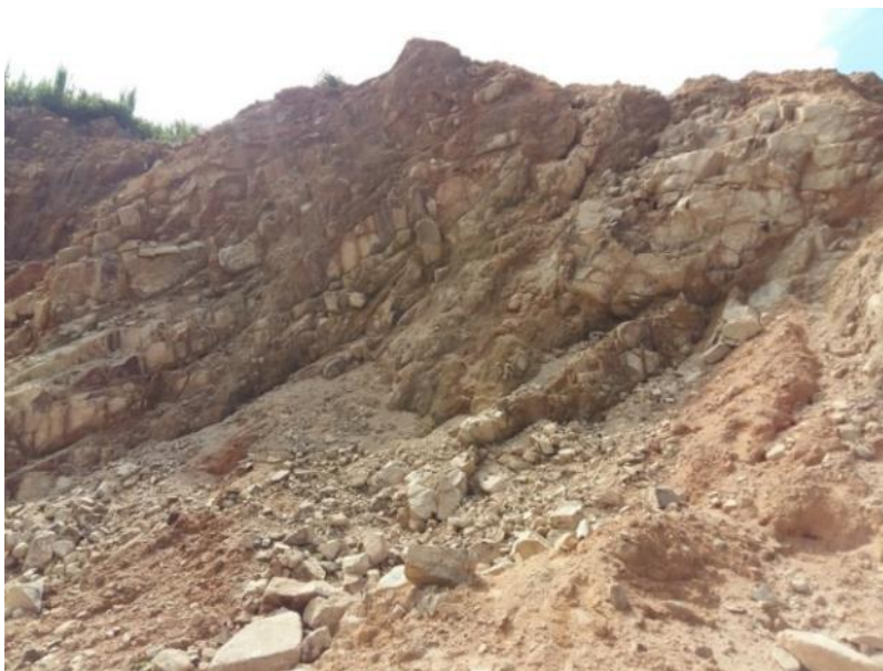
Figura 286 Caída de rocas asociado a un grado de fracturamiento intenso en el Neis de San Lucas (Coordenadas -74,05228, 8,95581).
