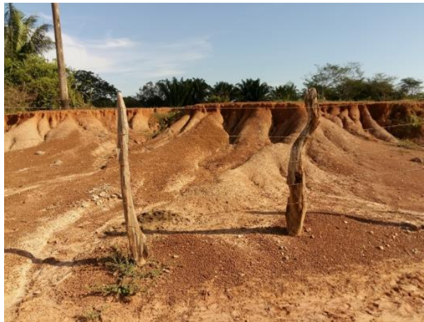
Figura 75 Cárcavas en Lodolitas de la Formación Zambrano en el cruce Guamal - Hatoviejo. (Coordenadas -74,17843W, 9,20834N).
