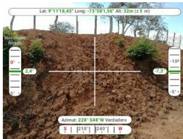
Figura 289 Deslizamientos por flujo de magnitud baja en la Vía Trébol – Mondegullo (Coordenadas 9,18835, -73,96689)
